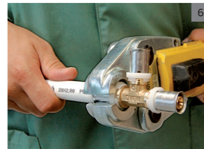
Verpressung mit TH Pressbacken
