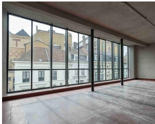
**Bild 8** – Für die hochwärmegedämmte Fassadenkonstruktion wurde zur Strasse hin und bei allen Fenstern und Türen nach aussen Jansen VISS und VISS Basic verwendet. Die beiden Systeme von Jansen eignen sich sowohl für Neubauten wie auch für das Bauen im Bestand. Entsprechend der statischen Erfordernisse, der Scheibengrösse und der Füllelementdicken werden die technisch und wirtschaftlich optimalen Komponenten aus dem Systembaukasten gewählt. (jansen.com)
