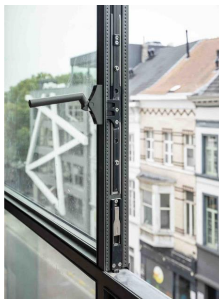
Photo 4 - Dans la grande salle panoramique à l'étage supérieur, on a utilisé les fenêtres à la française à deux vantaux Janisol Arte 66 qui, avec leurs cadres étroits, répondent aussi particulièrement aux exigences de la conservation des monuments. (iansen.com)
