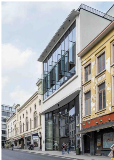
Photo 2 - L'entrée largement vitrée conduit les visiteurs directement dans l'époustouflante rotonde vers le nouveau café ainsi que vers la bibliothèque municipale, également intégrée dans la réaffectation et l'utilisation publique. (jansen.com)
