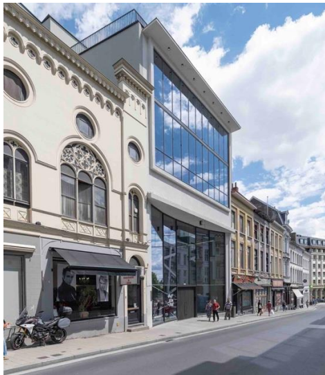
Photo 1 - Après un incendie, le Cirque d'hiver de Gand a été reconstruit dans un style moderne avec une façade panoramique généreusement vitrée donnant sur la Lammerstraat. À partir de 1943, le bâtiment a servi de garage. Avec la rénovation complète et la transformation en centre culturel, les systèmes VISS et VISS Basic de Jansen ont été utilisés pour la construction de façade à haute isolation thermique au rez-de-chaussée. (iansen.com)
