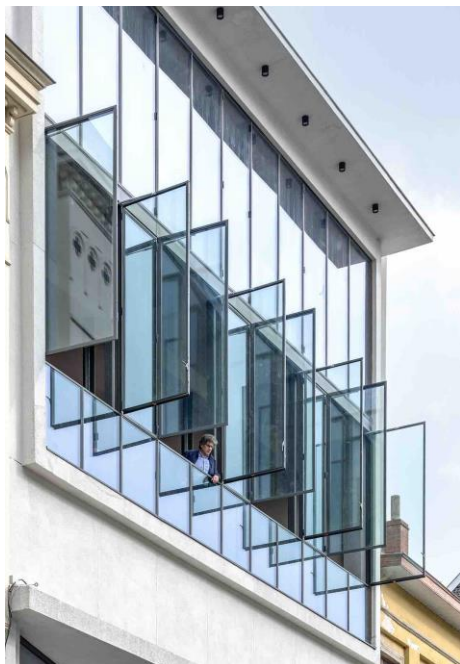
Photo 3 - Dans la grande salle panoramique à l'étage supérieur, on a utilisé les fenêtres à la française à deux vantaux Janisol Arte 66 qui, avec leurs cadres étroits, répondent aussi particulièrement aux exigences de la conservation des monuments. (jansen.com)
