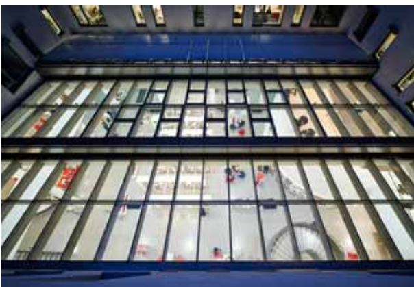
SLB_pic_06: Mit einer Glasfläche von rund 250 m 2 dient das Atrium der Belichtung des sehr tiefen Bibliotheksraums im Erdgeschoss. Im südlichen Drittel schützen Lamellen vor allzu viel Sonnenstrahlung.
