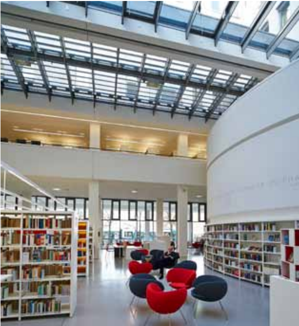
SLB_pic_08: Die grosszügige Überkopf-Brandschutzverglasung schafft einen lichten Innenraum, der seine Entsprechung in dem neuen Nutzungskonzept mit möglichst offenen Freihandzonen findet.
