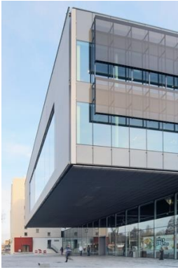
Bild 3: In den Obergeschossen wird die natürliche Belüftung der Räume über VISS Parallelausstellfenster gewährleistet. Auf diese Weise kann die Wirkung der reinen Ganzglasoptik perfekt erhalten werden.
