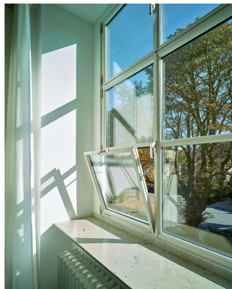
pic_06_MS LWL_CF012934.tif: Das „Fenster im Fenster“, ein in den Drehflügel integrierter Kippflügel, ist eine objektspezifische Sonderkonstruktion aus dem Stahlprofilssystem Janisol Arte 2.0.
