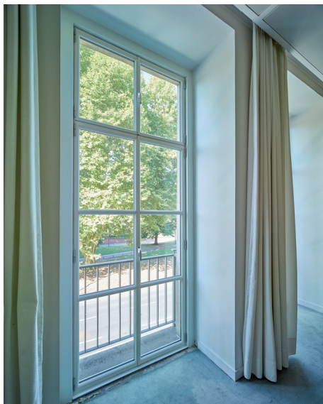
pic_05_MS LWL_CF017991.tif: Die Fenstertüren aus Janisol Arte 2.0 im Europazimmer sind 3,55 m hoch und wurden mit obenliegenden Öffnungsfügel ausgebildet.
