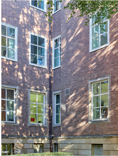
pic_03_MS LWL_CF012894.tif: Während die Fenster des EG in Sandsteingewänden sitzen, wurden die Blendrahmen der oberen Fenster seinerzeit in Fenstergewände aus Stahlblech montiert.
